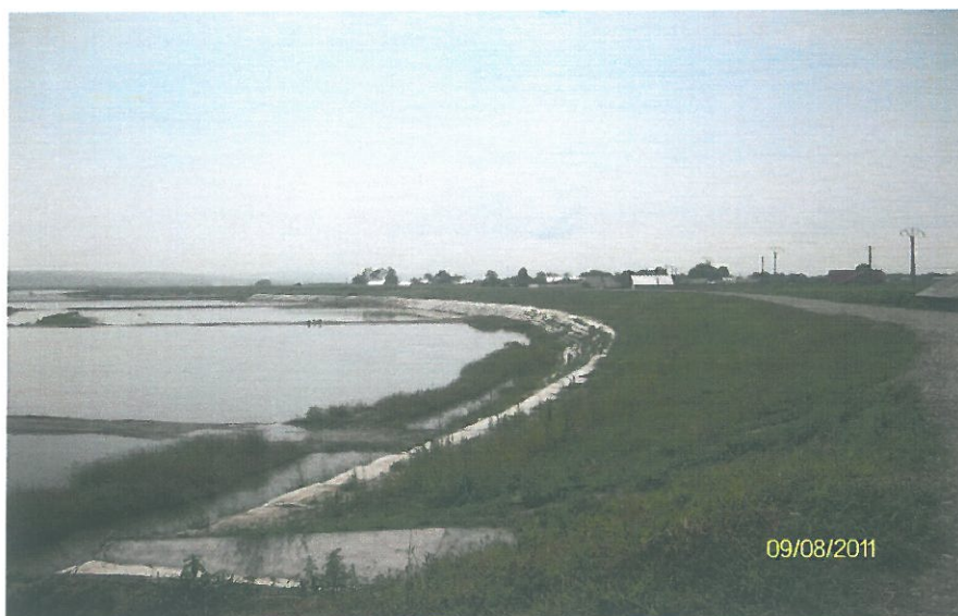
Fig. 3 – Lucrări de îndiguire pe malul drept al râului Siret pe tronsonul Șerbești, Siretu, Schineni, Săucești
